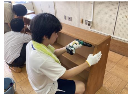
古い書棚の解体
